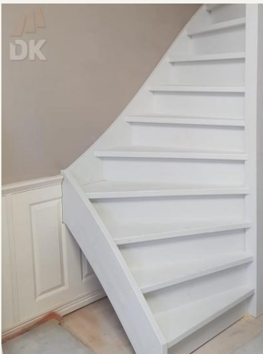
Voorbeeld van een dichte trap
